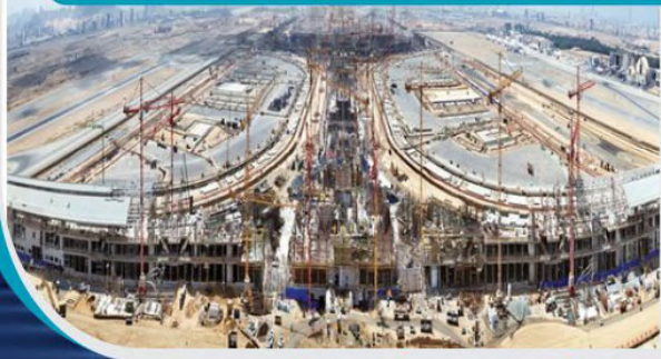
MAINTENANCE HANGER - JEDDAH
